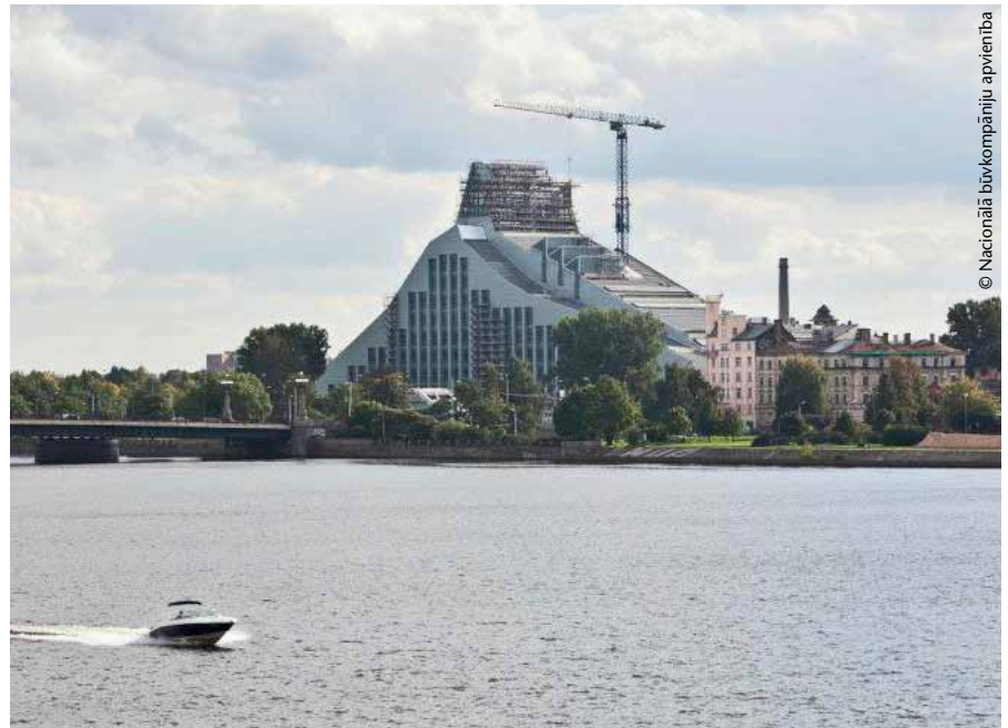
Stand der Bauarbeiten im Oktober 2011 von der Altstadtseite aus gesehen
