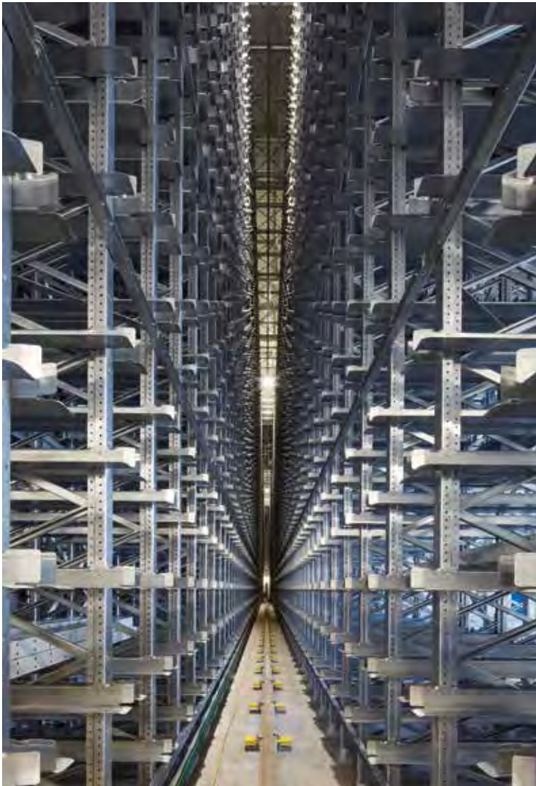
Gasse des Hochregallagers, Breite: 84 cm (27. Okt. 2015)
