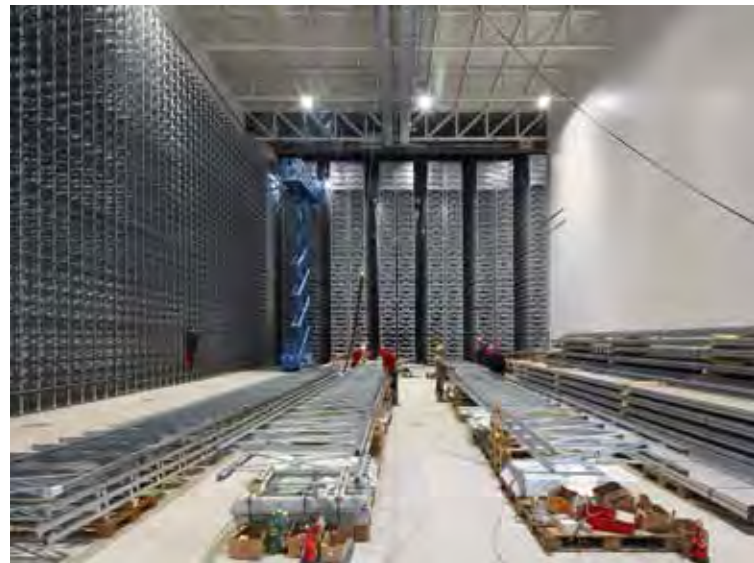
Die Gestelle des Hochregallagers im Bau (18. Sept. 2015)
