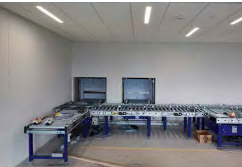
Kommissionierraum im Verwaltungsteil, mit den Schleusen zum Hochregallager (21. Okt. 2015)
