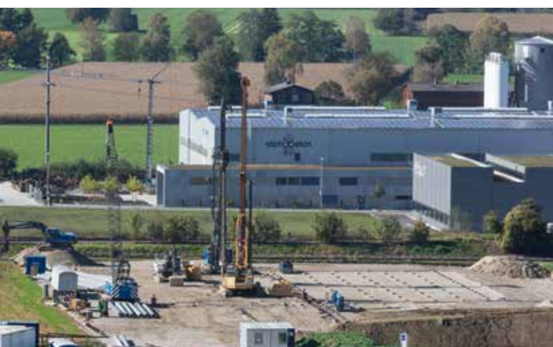
Fundamentierung mit Rammpfählen (19.10.2014, Urheber: U. Niederer)
