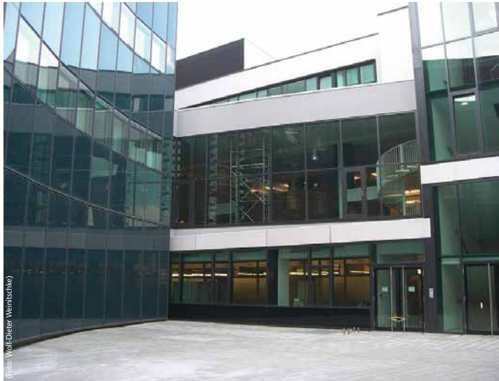
Abbildung 1: Campus-Innen mit Nachtzugang zur Bibliothek
