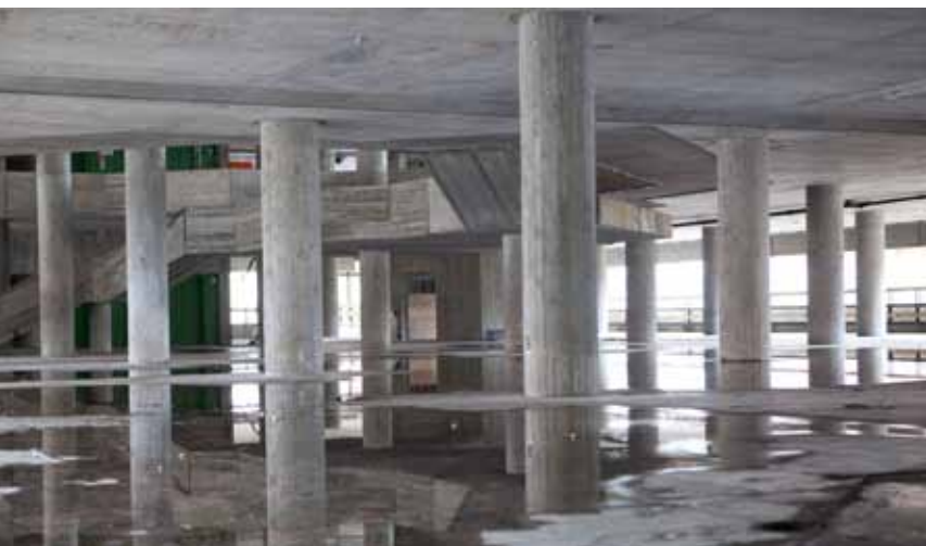
Abbildung 3: Entkerntes Dachgeschoss (Foto UB)
